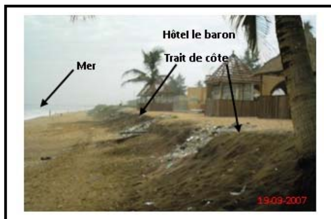
Figure 3. Menace d'érosion à la hauteur de l'hôtel le Baron à Port-Bouët.
