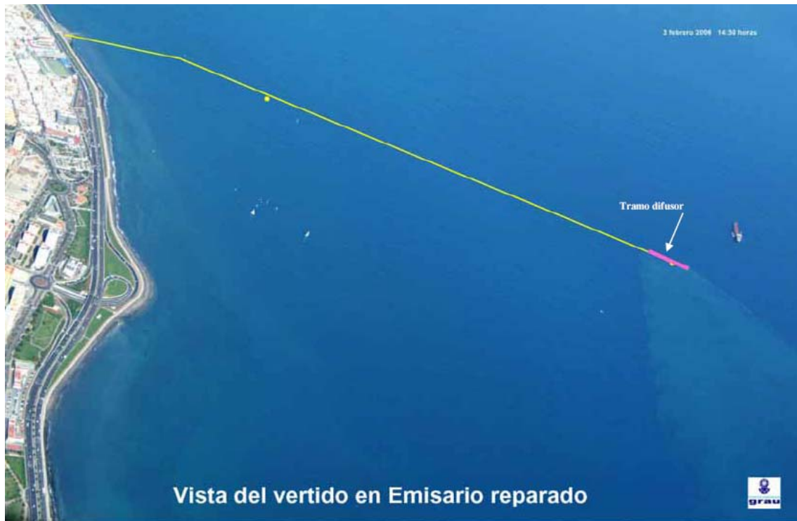
Figure 6. Vue aérienne du rejet avec l'émissaire réparé muni d'un multi-diffuseur.
