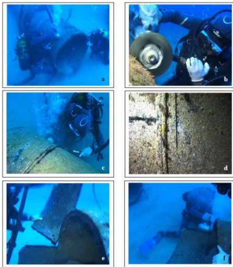
Figure 5. Diverses étapes de la découpe de la conduite.
