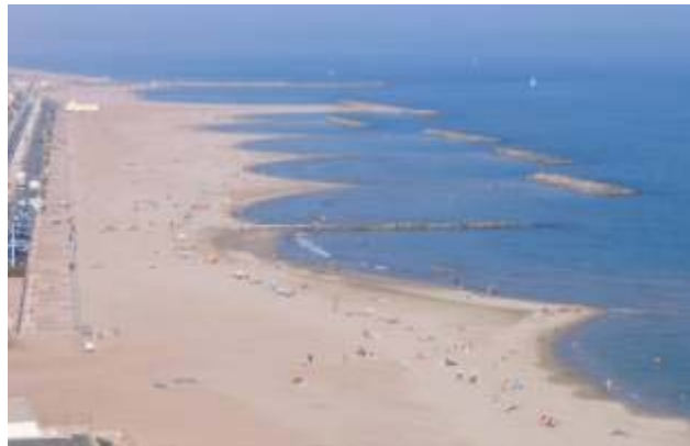
Figure 3. Aménagements et ouvrages côtiers à Valras (Hérault) : jetée portuaire, brise-lames et épi en enrochements naturels (du fond vers l'avant de l'image) (© CETMEF).
