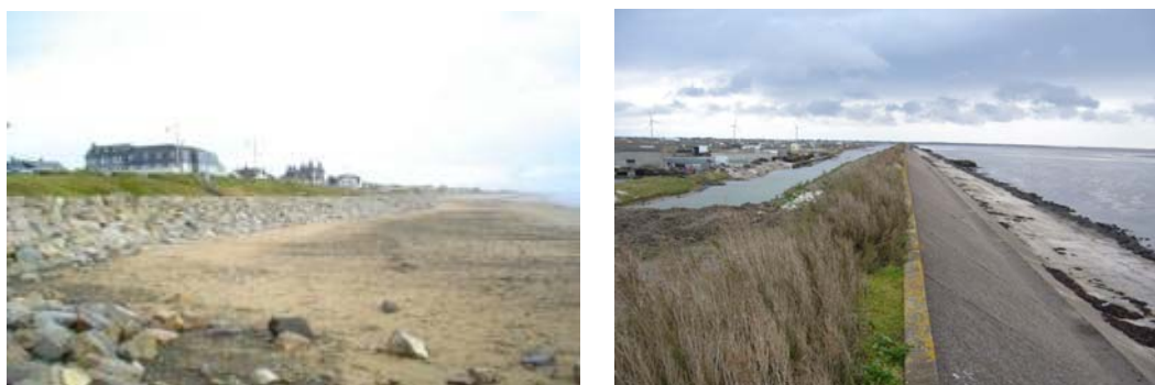
Figure 2. Exemples d'ouvrages longitudinaux : perré en enrochements à Barneville (Calvados, à gauche) et digue frontale à Beauvoir-sur-mer ((Vendée, à droite) (© CETMEF).
