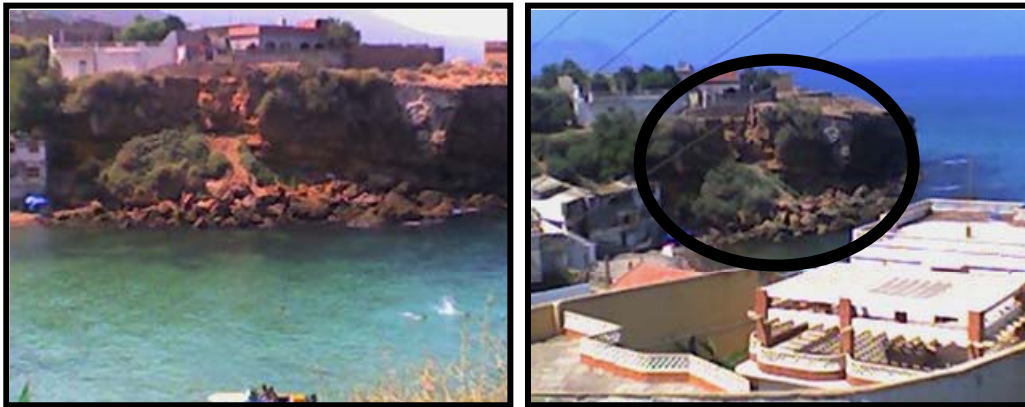
Figure 2. Effondrement de la falaise menaçant de nombreuses installations touristiques le long de la côte de Kristel.
