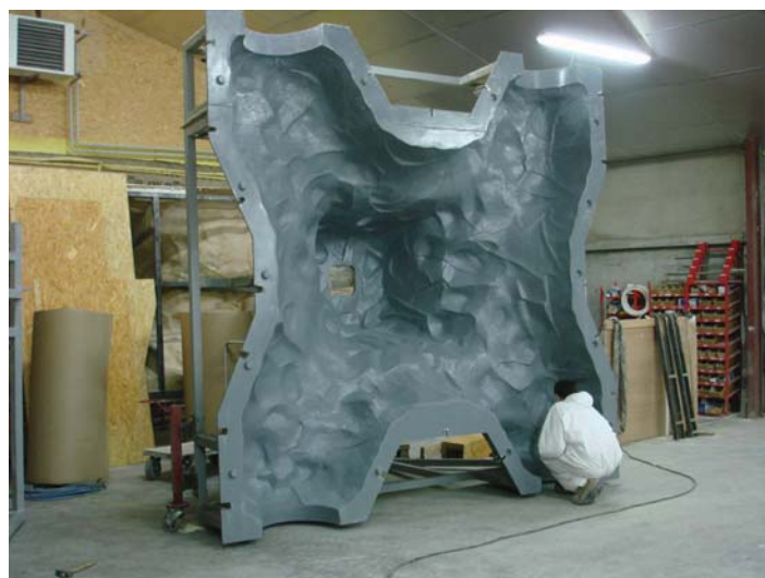
Figure 5. Fabrication d'un coffrage ECOPODE™.
