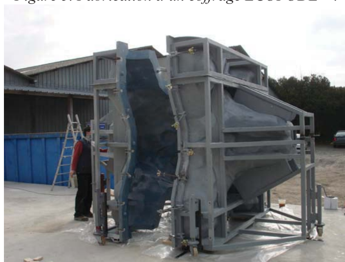
Figure 6. Vue d'un coffrage ECOPODE™ terminé.
