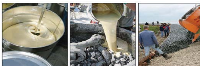
Figure 2. Les étapes de mise en oeuvre d'un enrochement lié par Elastocoast®.
