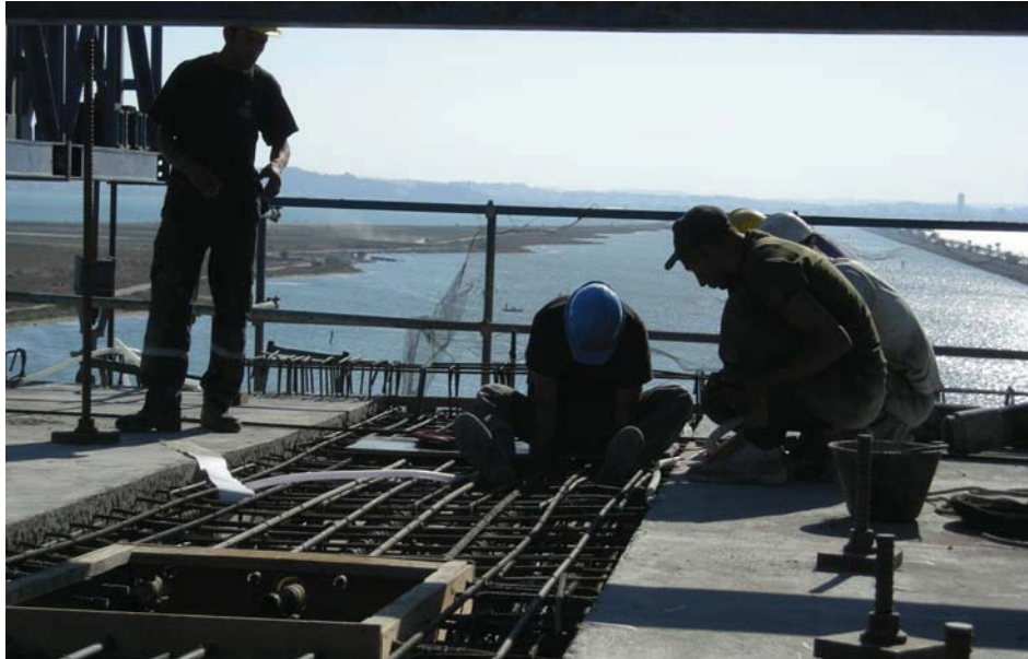
Fig. 2. Pose d'extensomètres dans le tablier.
