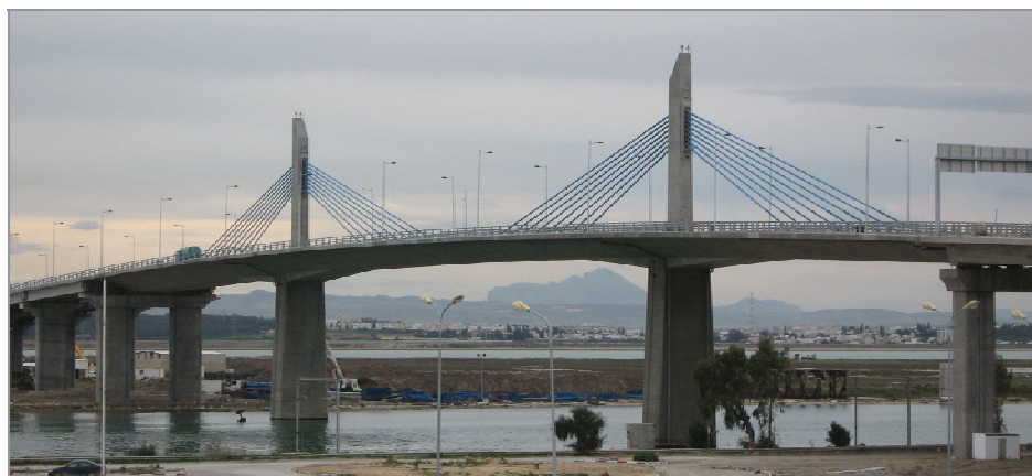
Figure 1. Vue générale du pont de Radès-La Goulette.
