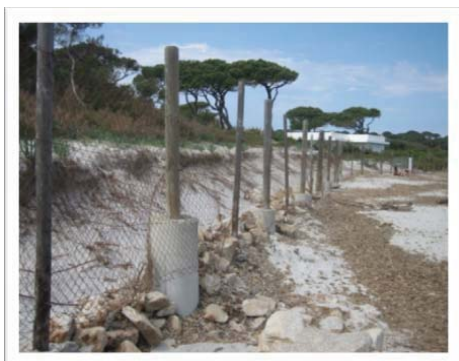
Figure 1. Erosion du massif dunaire sur la côte varoise (France).
