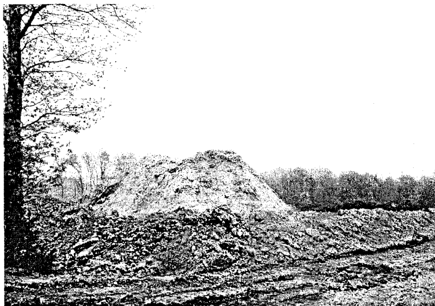
Photo 4 : Aménagement des parcelles du site de la Vicomté sur Rance : - en premier plan : les digues en terre végétale entourant les parcelles. - en arrière plan : les sédiments dragués, plus clairs, s'égouttent en attendant leur mise en place.
