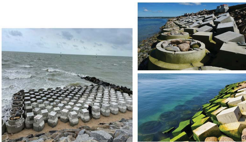
Figure 6. Double cube et ACCROBERMTMII. A droite sur le site de Ouistreham et à gauche sur le site de la rade de Cherbourg, digue du Collignon (crédits photos Dominique Mouazé, M2C Caen).
