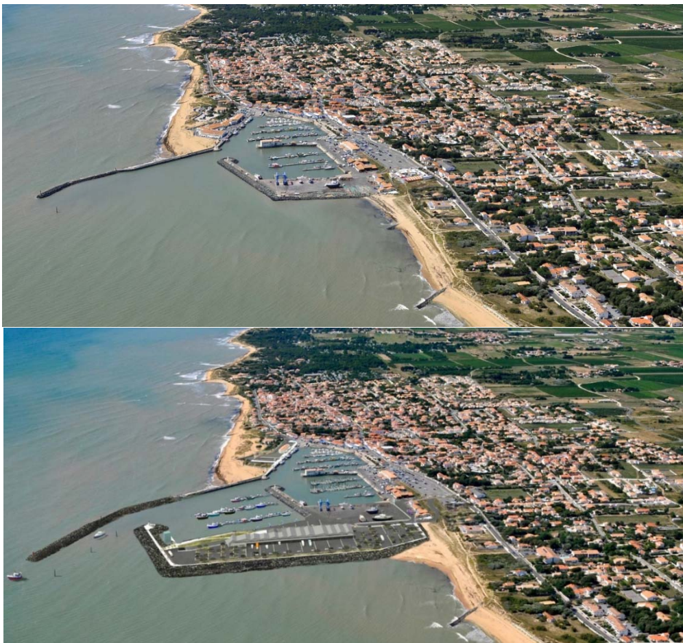
Figure 1. Vue aérienne du port de la Cotinière. Haut : avant travaux. Bas : photomontage du projet.
