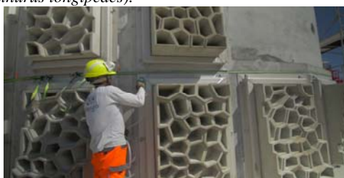
Figure 7. Mise en place des Panals.
